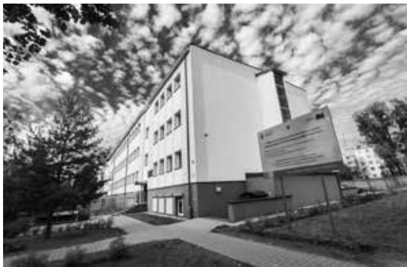
Rysunek 1. Widok budynku nr 65 w aktualnym stanie
